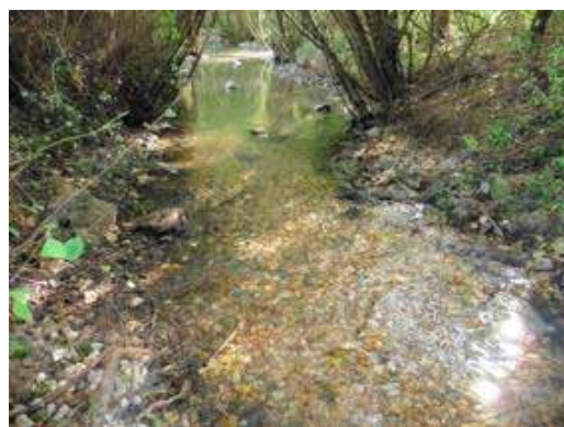
Après travaux : écoulements diversifiés avec alternance radiers, plats et fosses. Du gravier alluvionnaire a été ajouté comme support de fraie.
