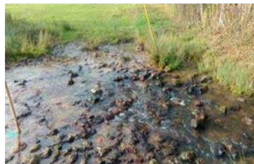
Radier après intervention
