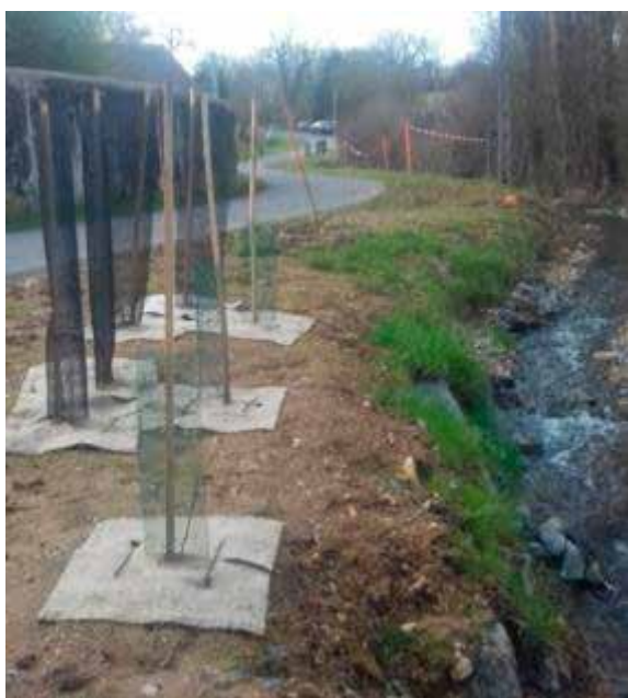
La ripisylve a été replantée sur une longueur totale d'environ 140 mètres. Les plantations réalisées les années passées ont également été entretenues.
