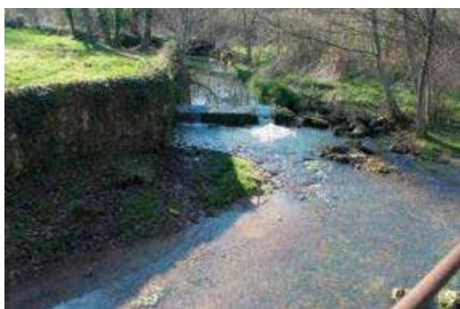
Seuil et gué avant travaux
