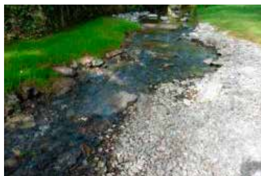
Seuil et gué après travaux
